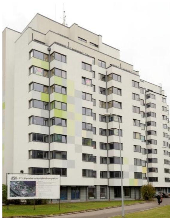
Siltinātā kopmītņu ēka Āzenes ielā 6, 8.
